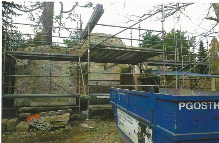
duo avec un ouvrier de l'entreprise. Après une dépose « à la Nantaise » de toute les façades en tuffeau et le piquage des enduit intérieur, il démarre la pose des piliers des ouverture jusqu'au sommier de l'arc. Les façade de l'Orangerie sont reposées à neuf et un enduit pierre vue sera appliqué à l'intérieur pour y laisser apparaître la maçonnerie en granite. Le coterie se plaît à restaurer cet ouvrage ou il devrai rester jusqu'à la fin du chantier.
