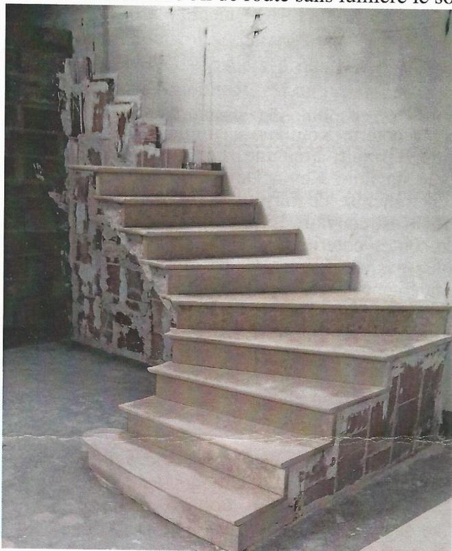
Percheron nous a fait débiter le stage par un peu de technologie, à savoir : éplucher les contraintes dues à l'environnement, rappel de Blondel, méthode de balancement puis l'épure et ensuite le travail commence! Éclaboussures, taille de briques, débit des marches, gâchage du plâtre, il y en a pour tous les goûts. Et c'est de bon cœur que le stage s'est déroulé les 14 / 15 & 16 juillet.
