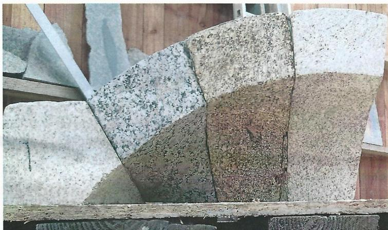
Malgré un collage foireux la veille du congrès, la coterie Graziana a réussi à rattraper et coller correctement sa coupole par enfourchement sur plan carré par Delarue en tuffeau de Camaret puis à finir de coller la maquette au 1/5 de l'arrière voussure Bretonne relevée avec la coterie Malissin et tailler par la douelle plate en copiant Freizier sur la méthode dite habituelle (une sacrée épreuve).
