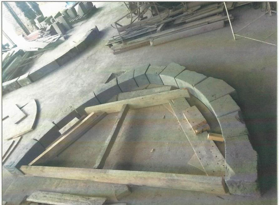
des blocs s'effectuant dans de la pierre de récupération qui est de la Volvic. La pose de pierre s'est très bien passée à l'aide de maçons qui m'ont prêté main forte pour la mise en place du chantier après la taille de tous les blocs. Tout se déroule bien, la pose est finie et le patron réfléchit à la suite de la consolidation. Je suis le 1<sup>er</sup> tailleur à être embauché chez Yves et il espère en voir d'autres venir chez lui pour de
