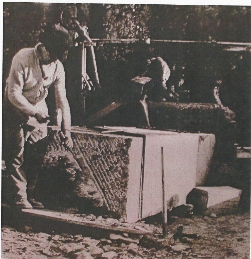
Ebauchage (un bloc aux faces brochées était moins taxé à la douane des états-unis qu'avec des faces lisses car produit de luxe)
