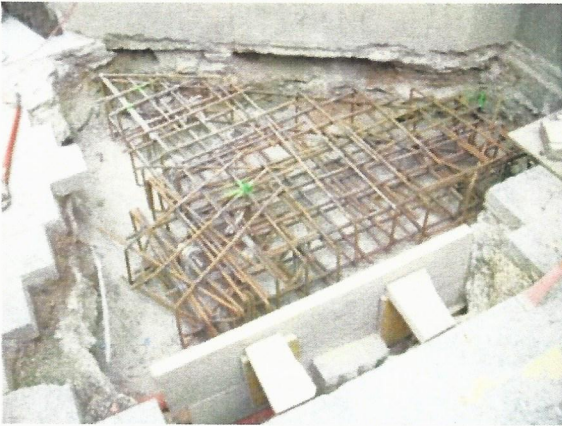
Ferrailage et implantation
