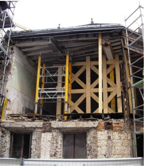
Etalement de la façade
