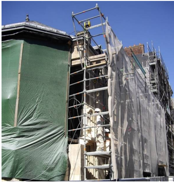
Démontage de l'angle de la façade
